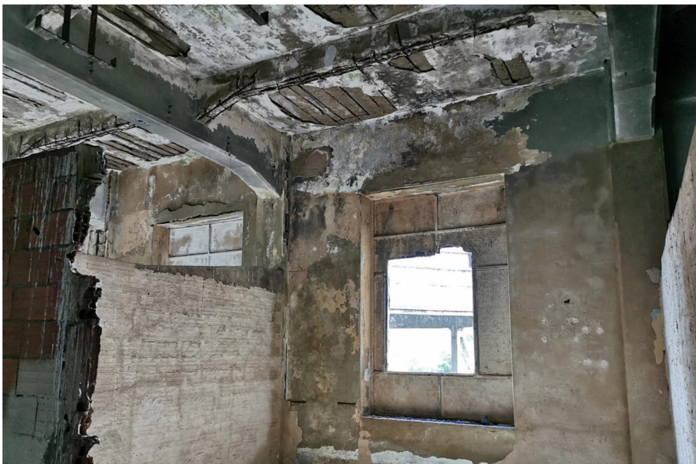
Due immagini del blocco dedicato alla trasformazione. Si evince la doppia orditura di travi che con il sistema Hennebique sostengono il solaio piano del blocco dedicato alla trasformazione e alla distribuzione.
