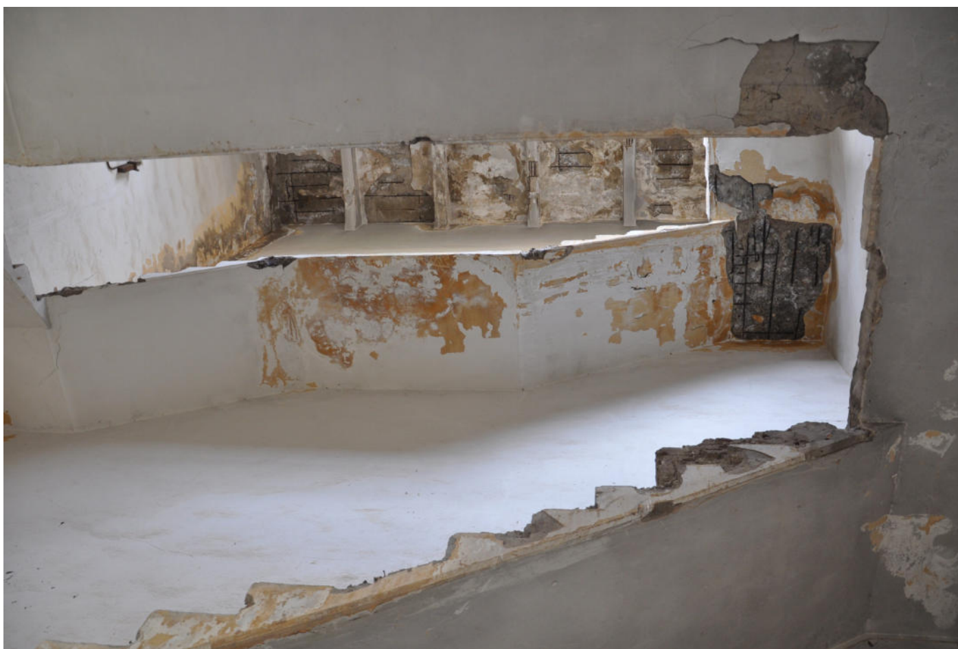
Uno scatto che ritrae il corpo scala dal basso mettendo in evidenza l'esilità dell'impianto strutturale costituito da una trave in calcestruzzo armato.
