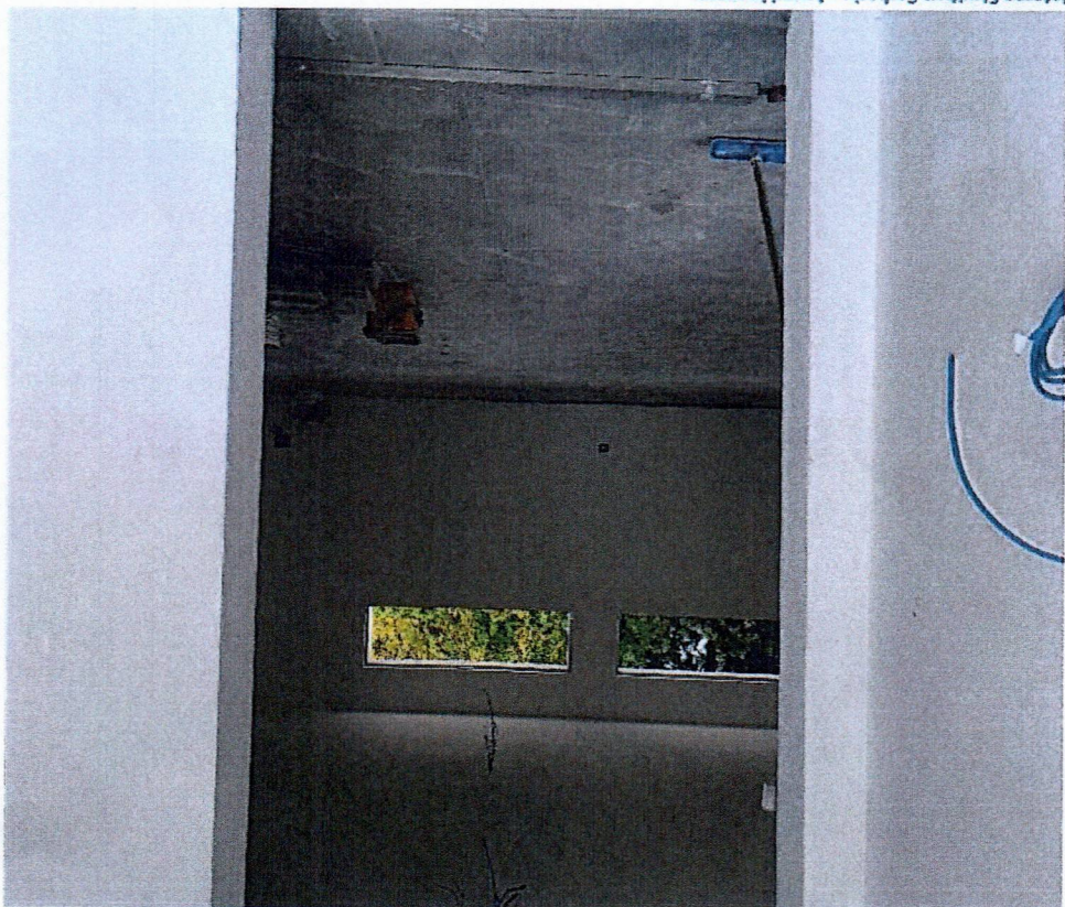
Interno Struttura Serbatoi - Lavori in corso
